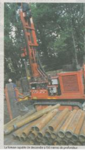
Le chenillard capable de descendre à 150 mètres de profondeur.
