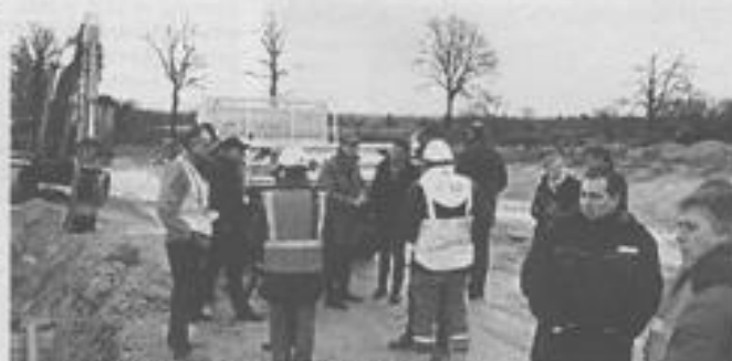
La 1 re partie de la nouvelle voie d'accès est en cours d'achèvement.
